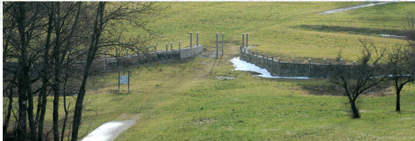
Teilrekonstruktion von „Tor G“ der keltischen Befestigungsanlage auf dem Heidengraben.
