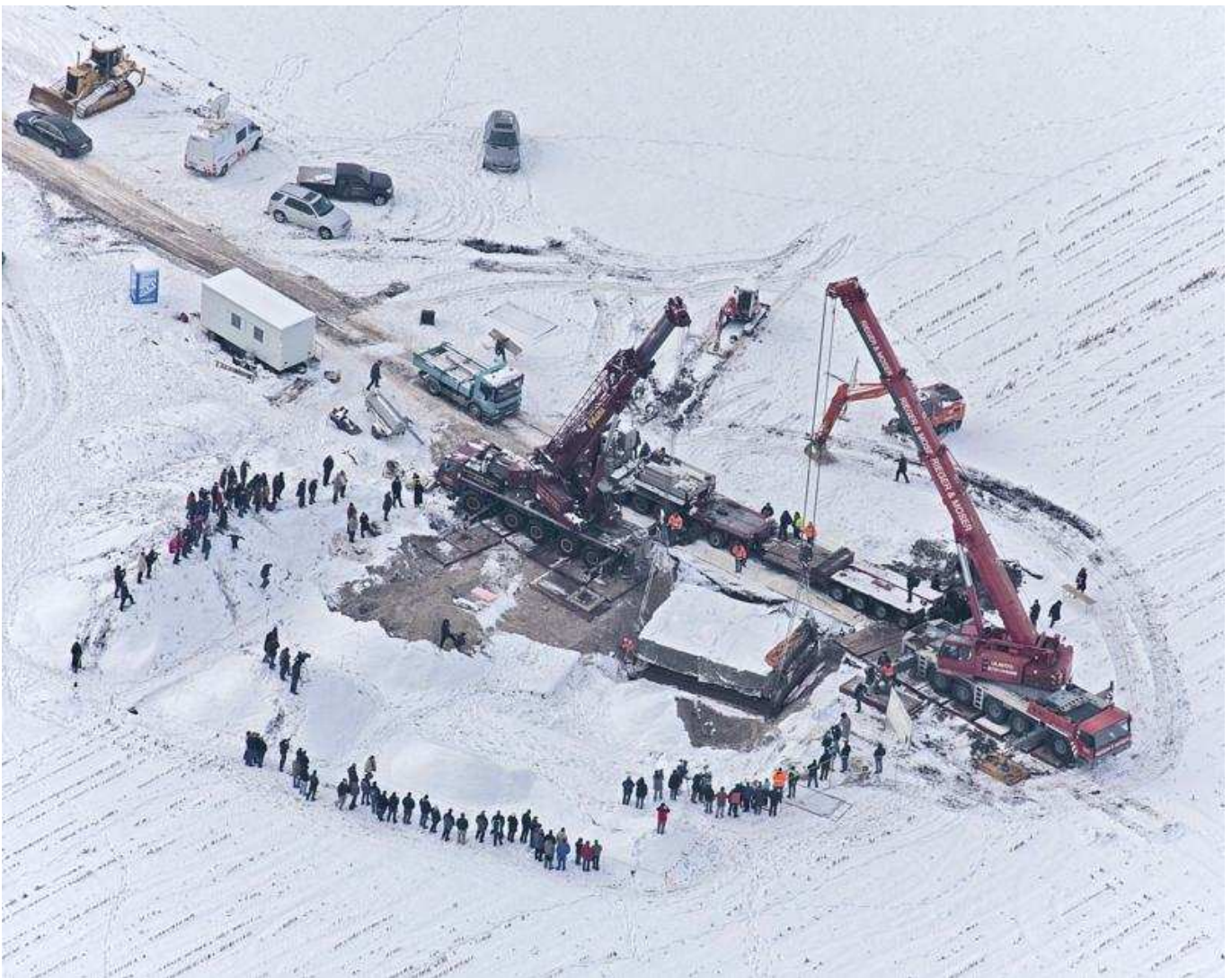
Bei winterlichem Wetter hoben zwei Schwerlastkräne den 80 Tonnen Block und verladen ihn auf einen Tieflader (Foto LAD/O. Braasch)
